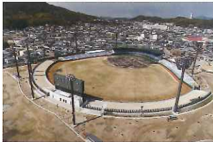
■公半大第10号 大新田公園本球場グラウンド整備工事 ■発注者/今治市
