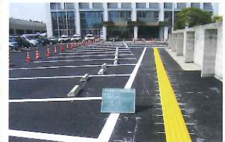
■本第12号 今治警察署舗装外工事 ■発注者/愛媛県
