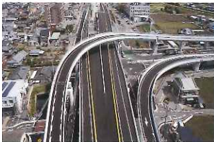
■平成25年度 北井門舗装(その1)工事 ■発注者/国土交通省四国地方整備局
