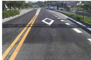
■平成26年度 松二管内舗装修繕工事 ■発注者/国土交通省四国地方整備局
