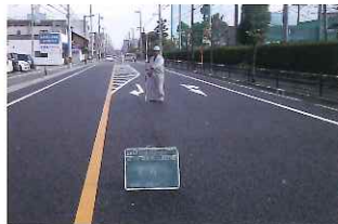
■防交舗修第63号の1 (国)317号舗装修繕工事 ■発注者/愛媛県
